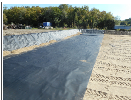
Réalisation en cours d'une alvéole
